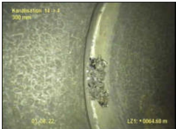
64.60 m Ablatzung an der Rohrverbindung 9 bis 10
