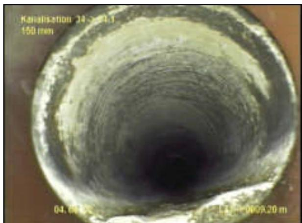
9.20 m Rohrmaterialwechsel: Beton
