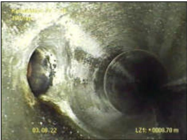
8.70 m Anderer Anschluss 10 Uhr, Saniert
