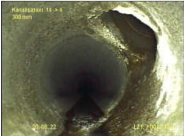
42.40 m Anschluss eingespitzt 1 Uhr
