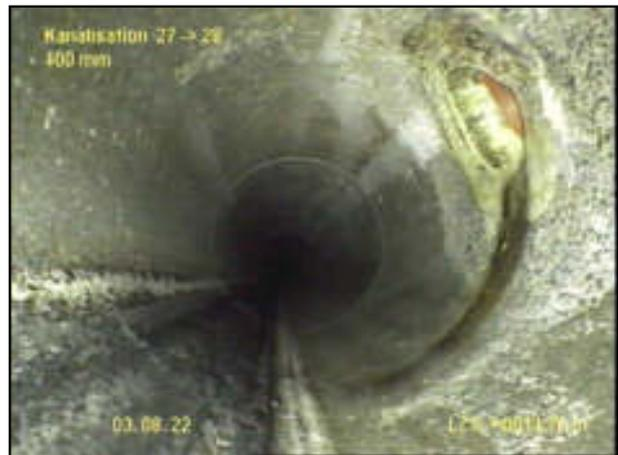
14.70 m Anderer Anschluss 1 Uhr, Saniert
