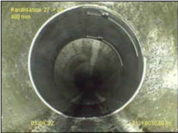
30.00 m Reparatur mit grabenlosen Verfahren 12 bis 12 Uhr, Quick-Lock
