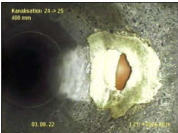
26.00 m Anderer Anschluss 12 Uhr, Saniert
