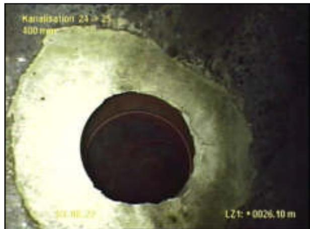
26.00 m Anderer Anschluss 12 Uhr, Saniert
