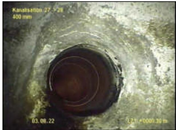
8.70 m Anderer Anschluss 10 Uhr, Saniert
